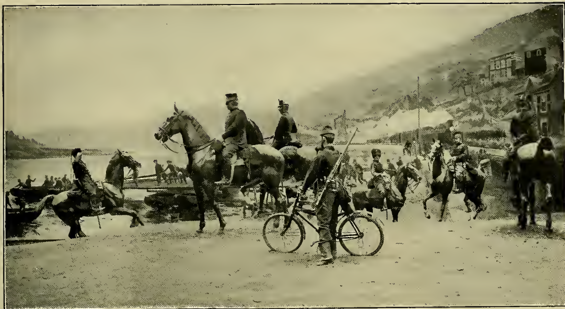
CONSTRUCTION D'UN PONT MILITAIRE A JUPILLE.
